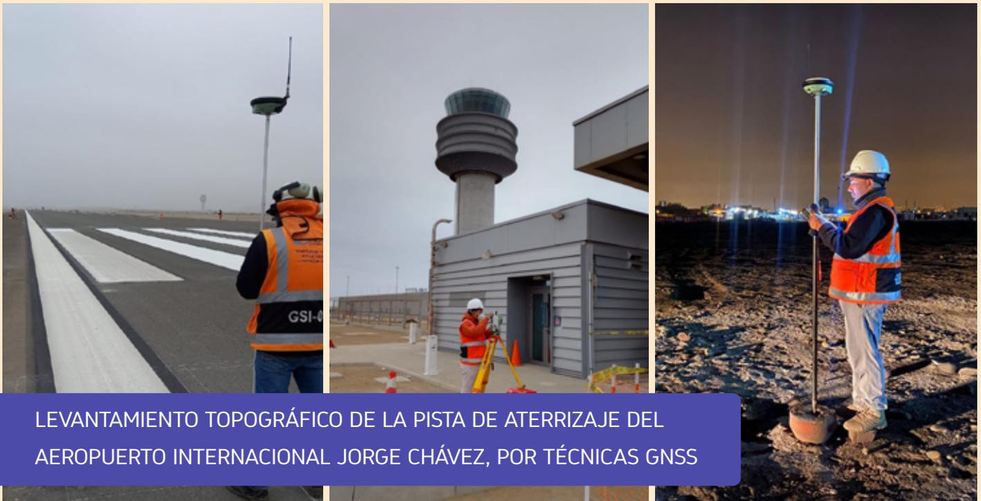
LEVANTAMIENTO TOPOGRÁFICO DE LA PISTA DE ATERRIZAJE DEL AEROPUERTO INTERNACIONAL JORGE CHÁVEZ, POR TÉCNICAS GNSS
